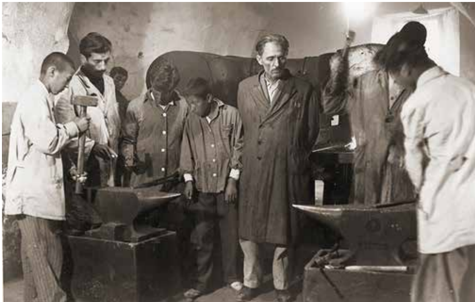
Mardin Artuklu Erkek Sanat Enstitüsü Demir Atölyesi ARTUKLU - Mardin Mesleki ve Teknik Anadolu Lisesi Arşivi
